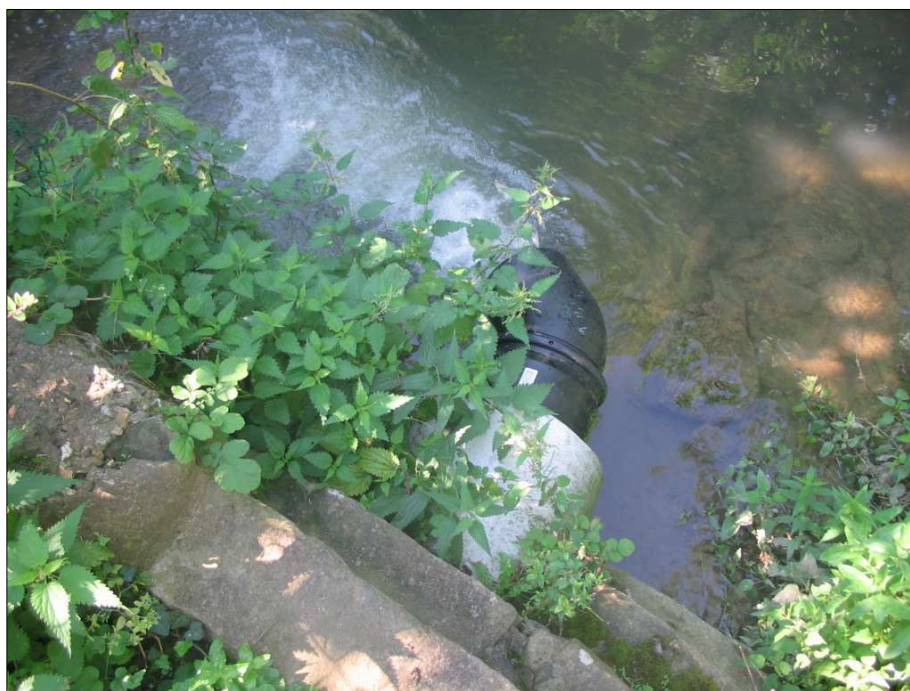
Photographie 10 : Ouvrage de rejet dans la Montcient, canalisation Ø300
