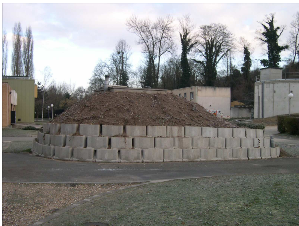
Photographie 4: Vue du forage F1 surélevé dans l'enceinte de l'usine d'eau potable.
