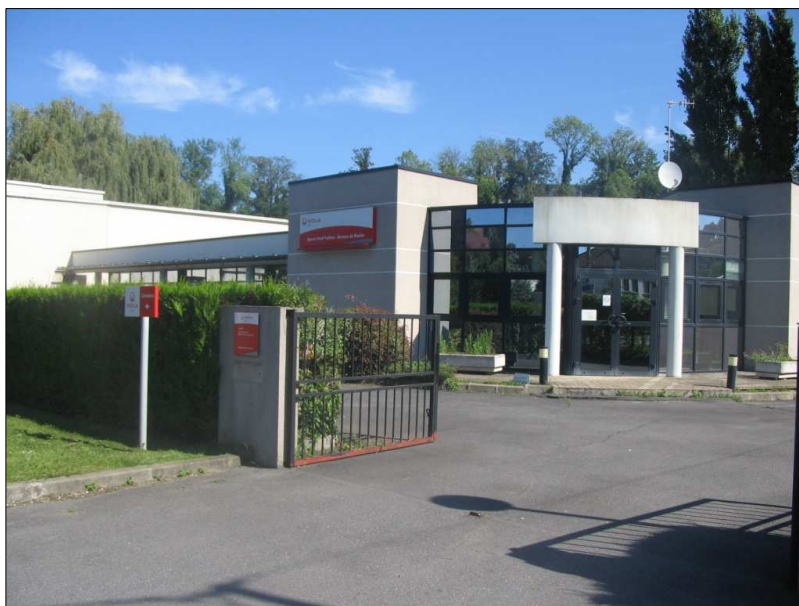
Photographie 1 : Entrée de l'usine d'eau potable de Meulan le long de l'avenue des Aulnes.
