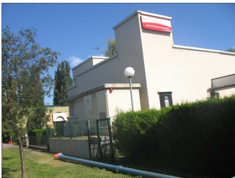
Photographie 2 : Vue de l'usine d'eau potable de Meulan.
