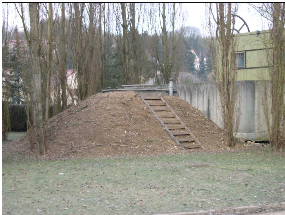
Photographie 5 : Vue du forage F2 surélevé dans l'enceinte de l'usine d'eau potable.
