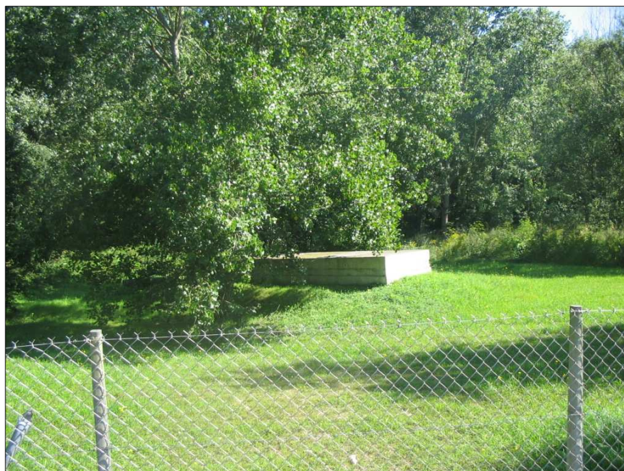
Photographie 6 : Vue du forage F3 clôturé au niveau du périmètre de protection immédiate.
