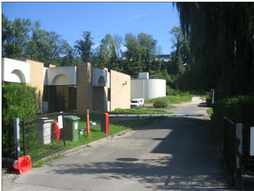
Photographie 3 : Entrée des véhicules dans l'usine d'eau potable de Meulan.
